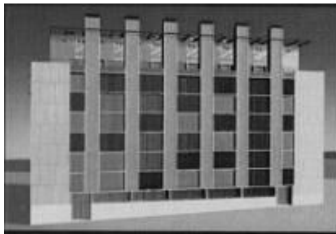
Figura 22. Bloco de moradias no Oeste de San Fermín (Madri) com chaminés solares integradas na fachada oeste. (Fonte: CIEMAT)
