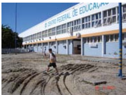
Figura 2.9- Início das obras de construção do Centro de Convivência da Unidade Florianópolis
