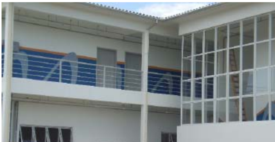
Figura - Vista interna do Bloco de salas de aula de Araranguá.
