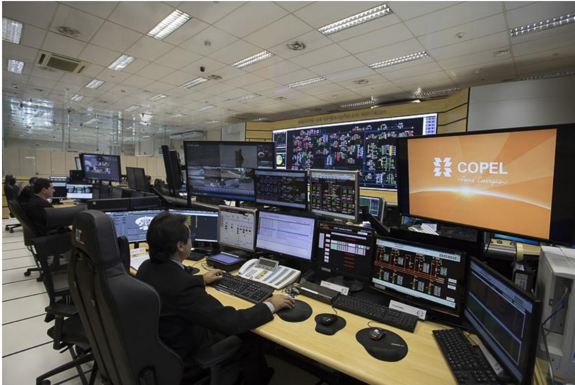
Figura 1 – Operador lidando com diversos equipamentos diferentes no Centro de Operação de Geração e Transmissão Copel (Foto: Copel)
