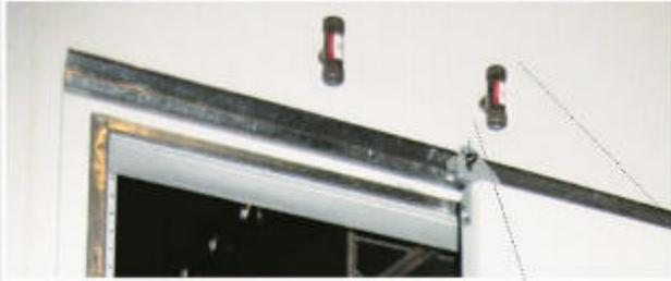
Tem a finalidade de equilibrar as pressões no interior das câmaras frigoríficas, compensando com entrada ou saída de ar. Opção com ou sem aquecimento.
