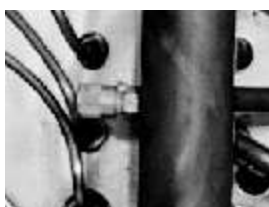
Válvula Schrader para medição de pressão de sucção
