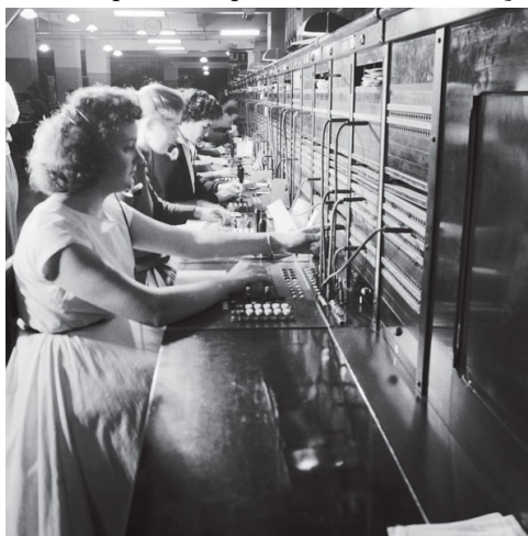
Figura 12 – Telefonista responsável por realizar a comutação de forma manual
